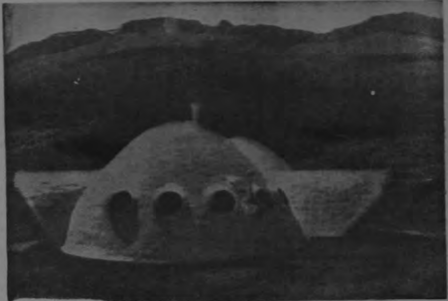
Casa Plástica de Ron Kessinger, de Golden, Colorado, semeja una estructura marciana. La construcción de cúpulas múltiples contiene 487 metros cuadrados de espacio habitable. Las paredes se forman con balones de plástico, rocios
